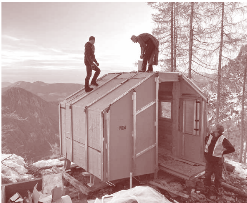
Zaključna dela postavitve bivača pod Ojstrico
